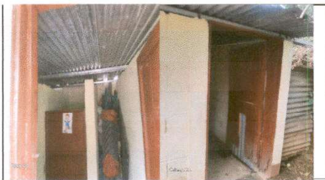
Foto 5: Sustitución de puerta
