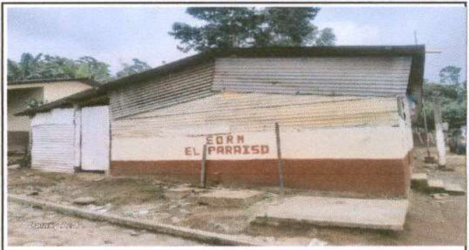
Foto 4: Reparación de muro perimetral de block 50 M2
